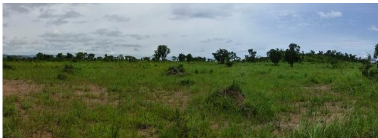
Site retenu pour la construction du poste électrique au Sud de la ville de Beyla.
