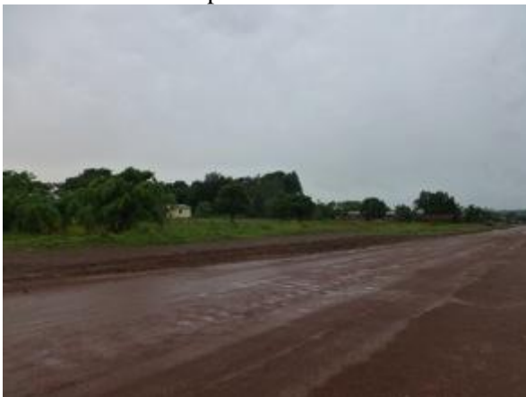
Elargissement de la N.1 au Nord de Tintioulen
